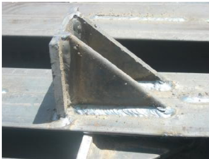
اجرای جوش گوشه و رعایت ضوابط آیین نامه ای
